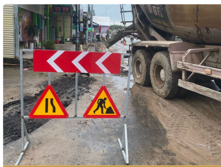
Rào chắn, biển báo an toàn khi thi công
