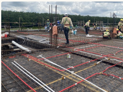
Lắp đặt cốt thép, ống kỹ thuật sàn BTCT
