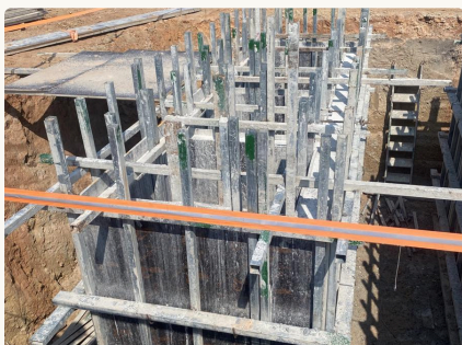
Ván khuôn, cốt thép tường bể ngầm
