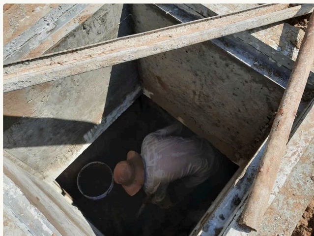
Hoàn thiện lòng hố ga
