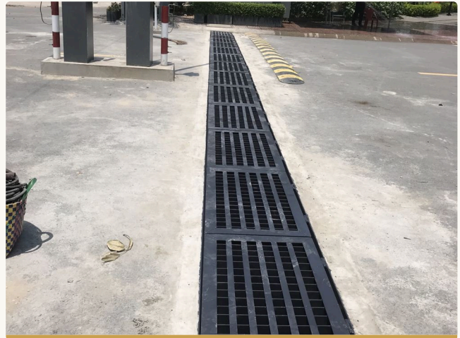
Mương thoát nước nắp gang tại cổng nhà xưởng
