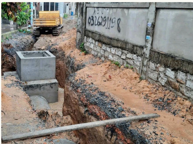
Đào mương đặt cống dọc tường rào, hố ga BTCT
