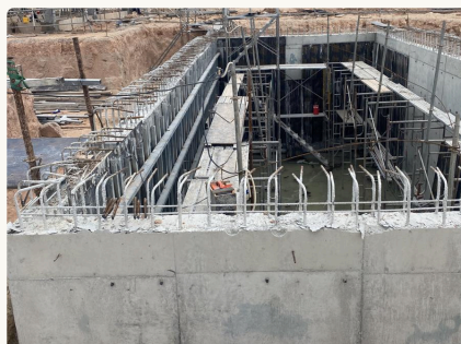
Tường bể BTCT sau tháo ván khuôn
