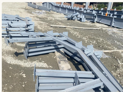
Cấu kiện khung thép tập kết tại công trường
