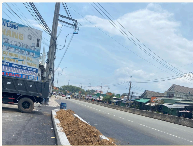
Thi công bó vỉa đảo phân luồng
