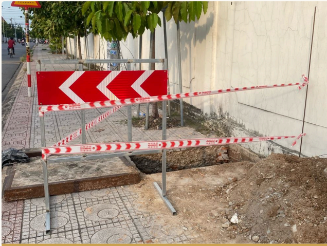
Đào vỉa hè, rào chắn an toàn – tuyến đầu nối dọc tường nhà xưởng
