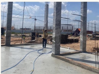
Cột BTCT, bảo dưỡng sàn bê tông
