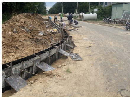
Thi công mương thoát nước dọc tuyến đường
