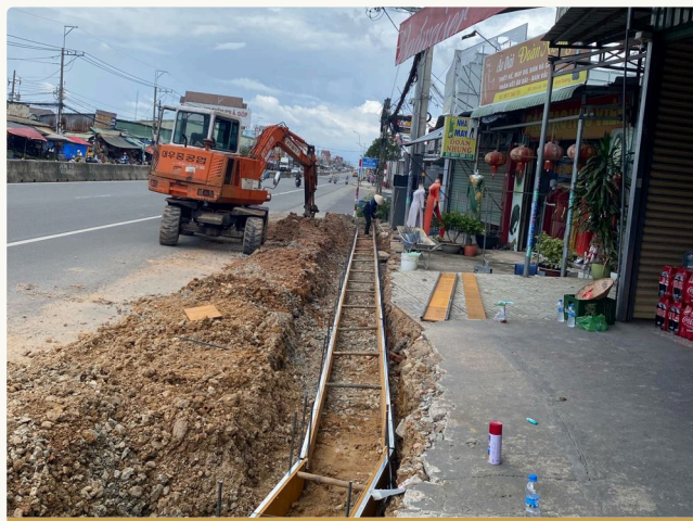
Lắp ván khuôn rãnh thoát nước dọc lề đường
