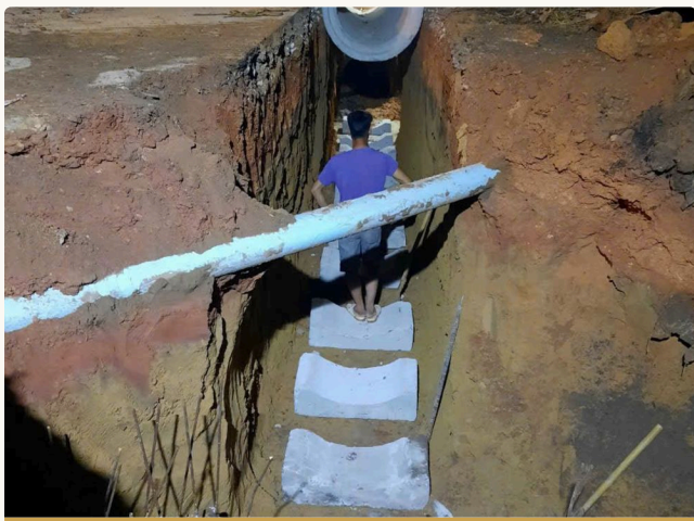
Lắp đặt cống BTCT trên gói đỡ (thi công ban đêm)
