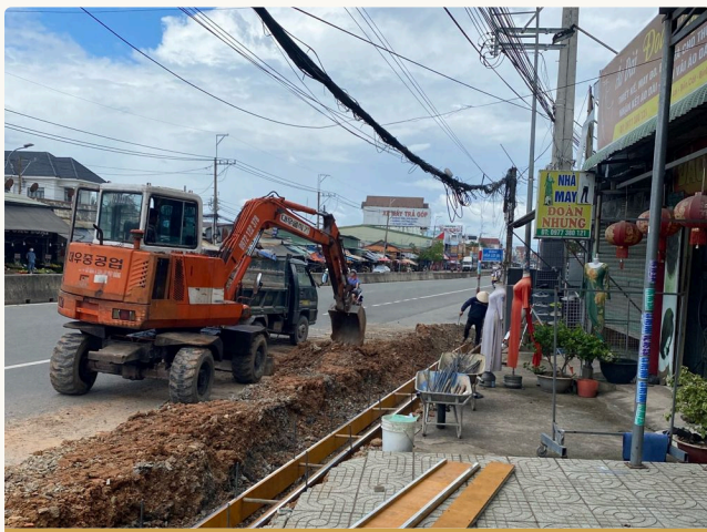
Đào rãnh thoát nước dọc lề đường
