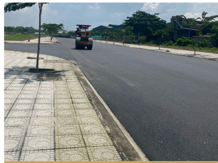
Mặt đường bê tông nhựa, vỉa hè hoàn thiện
