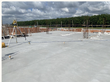
Sàn BTCT hoàn thiện, định vị trắc đạc
