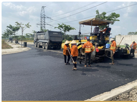
Thảm bê tông nhựa bằng máy rải
